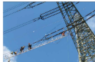
Construction de lignes électriques aériennes
