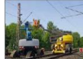
Construction de caténaires
